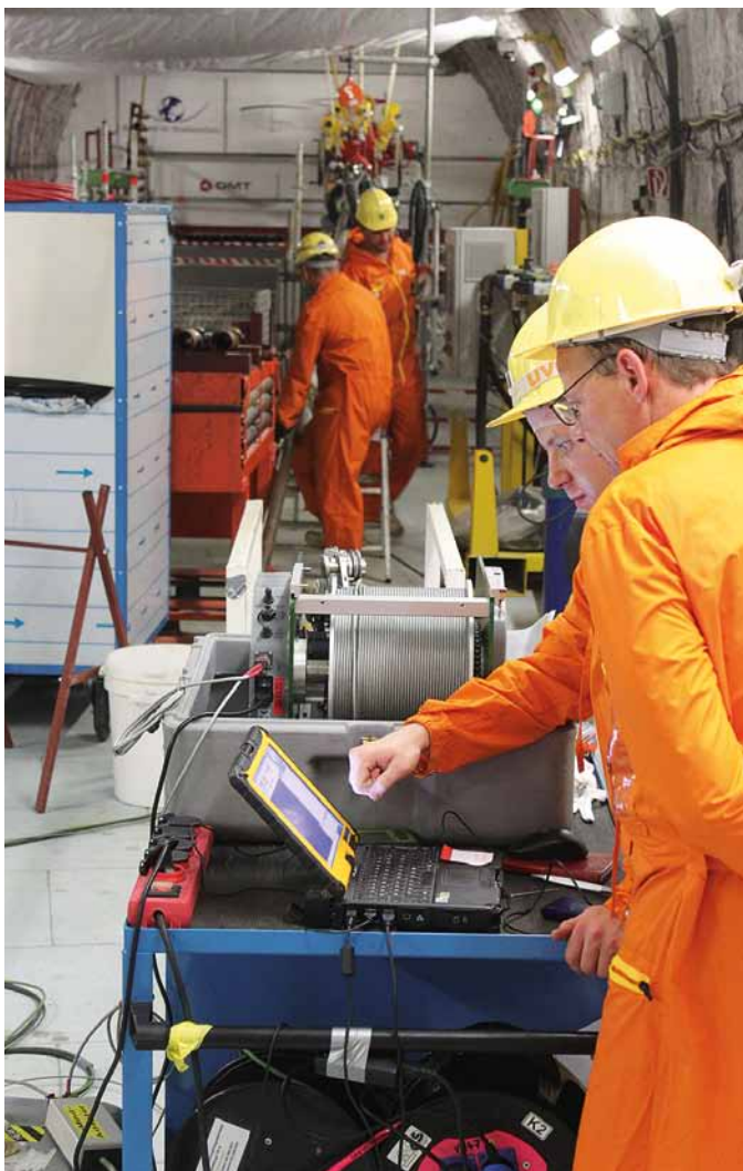
Bohrarbeiten im Rahmen der Probephase im Arbeitsbereich vor der Einlagerungskammer 7
