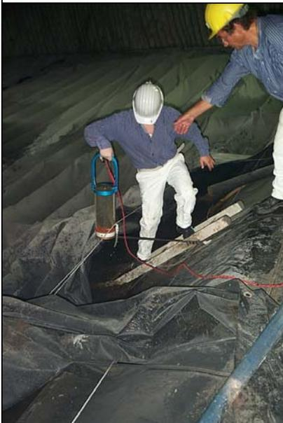
Photo 11: Probenahme SB1vu mit Schöpfgerät
