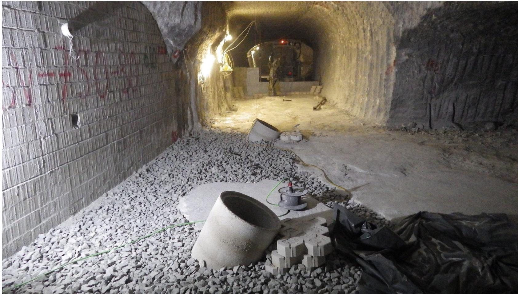
*Abbildung 3: SV-750-21, Katasterstelle P7500042, Vorbereite der Schachtringe im Schotterbett, redundante Schachtringsäule vor Zugang ELK 4/750, 08.11.2016*
