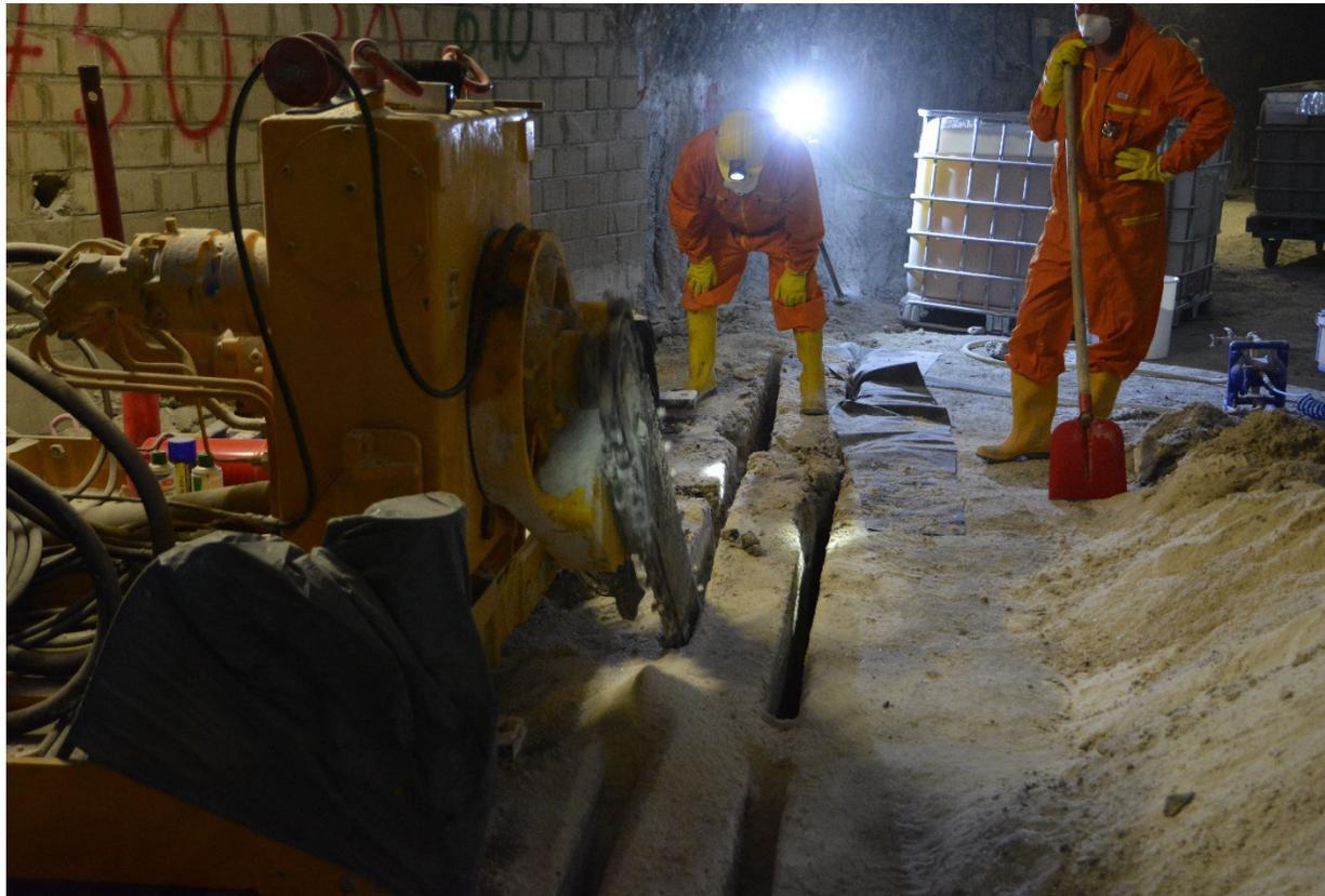
*Abbildung 1: SV-750-21, Katasterstelle P7500042, Vorbereitung der Sohlenschräme vor Zugang ELK 4/750, zwei parallele Schlitze im Abstand von 0,4 m und 1,0 m Tiefe, Zwischenbereich wurde herausgebrochen und mit Schotter verfüllt , 27.09.2016*
