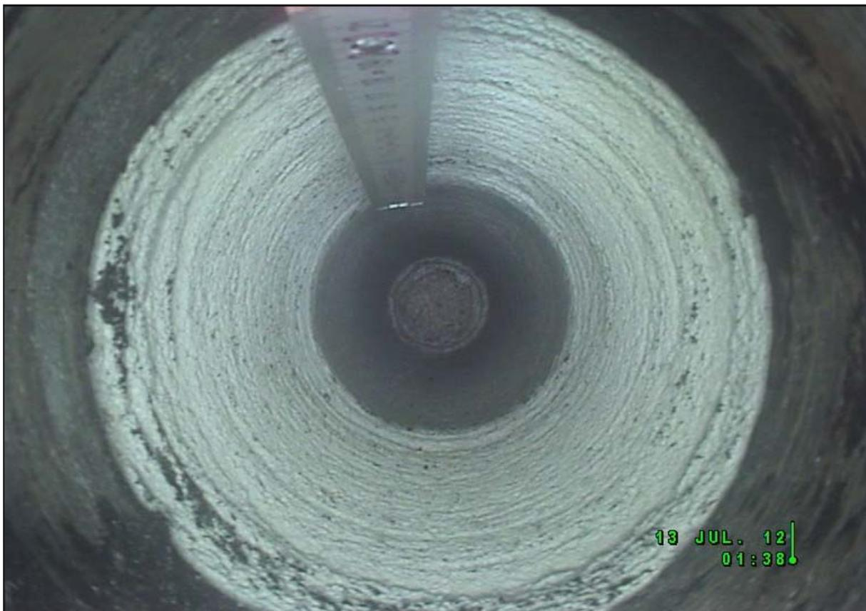
**Abbildung 9:** Aufbau Verschlussbauwerk, Bereich Asphalt-/Bitumenschicht (dunkel im Vordergrund), Ytongmauer (hell), Baustoffelement im Bohrlochtiefsten (dunkel)
