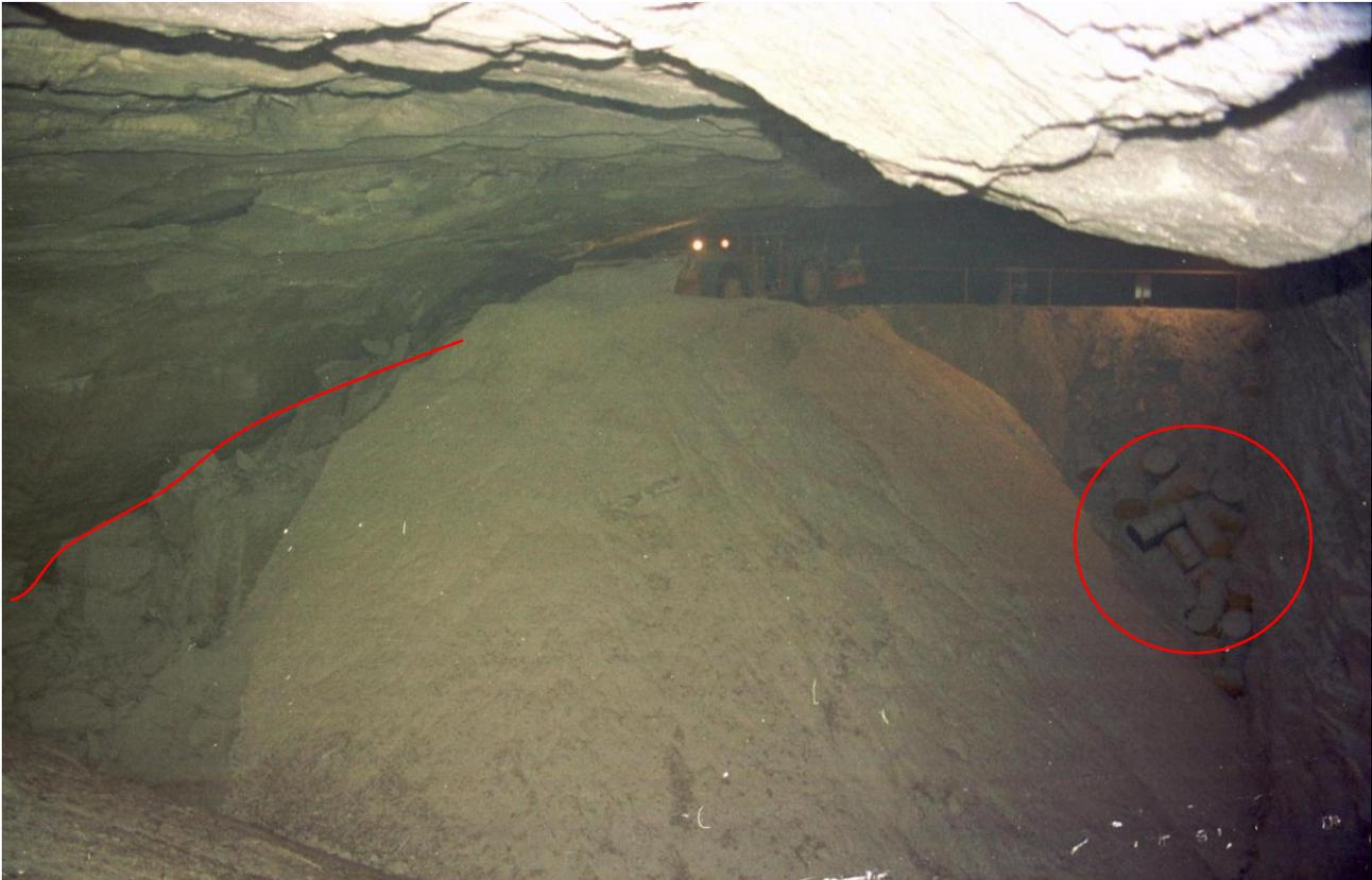
Abbildung 16: Verfüllmaßnahmen in ELK 7/725 im Jahr 1996, Überkippen der Abfallgebinde vom nord-westlichen Zugang aus mit Salzgrus mittels Fahrschaufellader, Asse-Archiv Nr.: Foto-249\_19960905-02\_725Ka7.jpg (DMT, 2014b).
