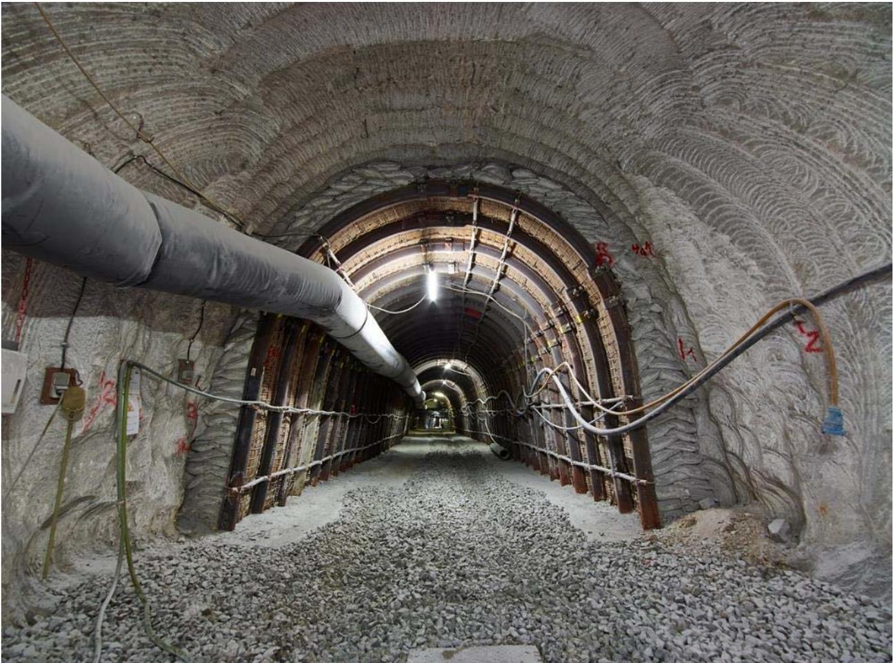
Abbildung 8: Gleitbogenausbaustrecke auf der 725-m-Sohle der Schachtanlage Asse II (Quelle: <https://www.bge.de/de/aktuelle-arbeiten/asse/2018/2/kw-72018/>)
