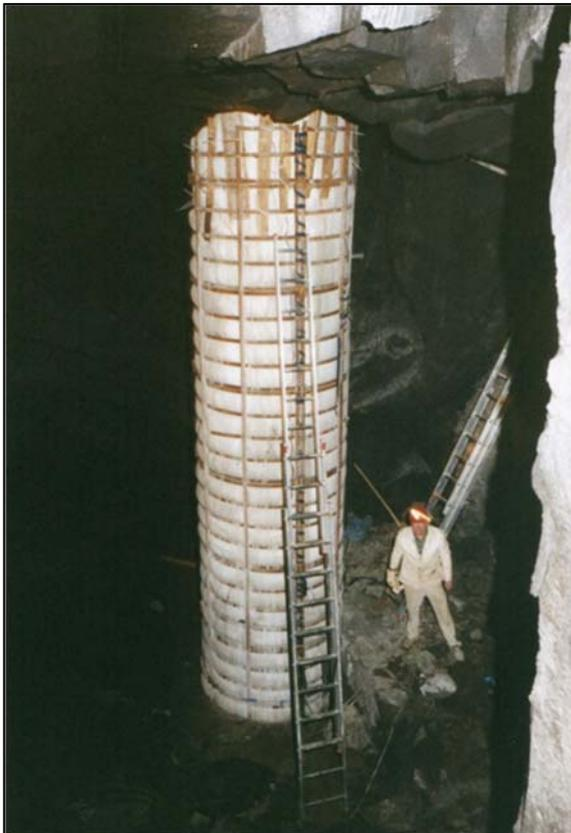
Abbildung 9: Betonstütze zur Abstützung der Firse (Quelle: Bullflex, BuM GmbH)
