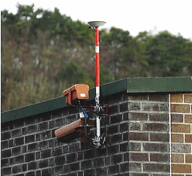
Abbildung 5: Basisstation für die GPS-RTK-Vermessung am Gebäude des Truppbüros in Wittmar.
