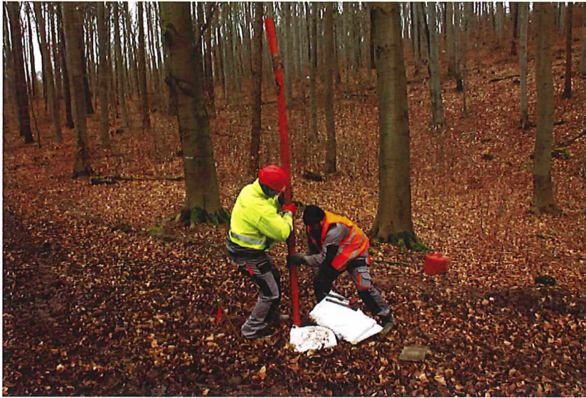
Abbildung 41: Ziehen der Verrohrung.
