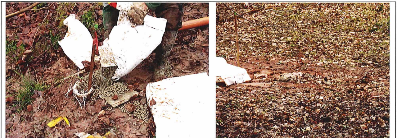
Abbildung 42: Füllen der besetzten Bohrung mit Bentonit (links) und für die Sprengung vorbereitete, mit einer Sprengladung besetzte Bohrung (rechts).
