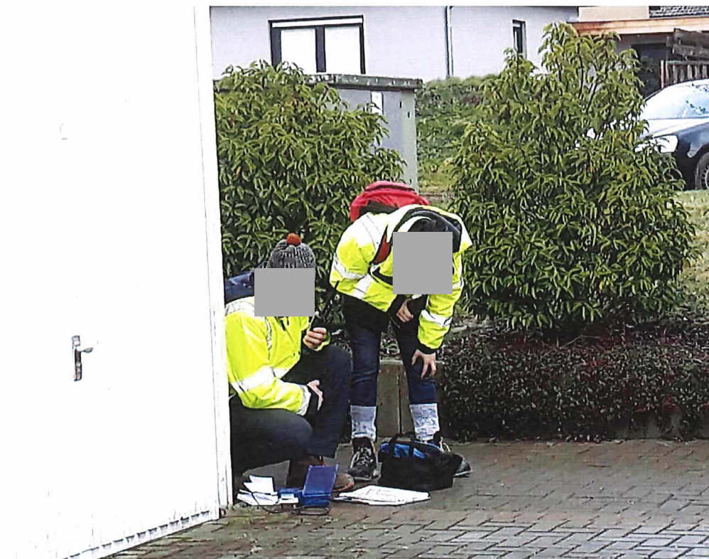
Abbildung 67: Erschütterungsmessungen (PPV) überwachen die durch die Anregung der seismischen Wellen erzeugten Erschütterungen an Gebäuden.
