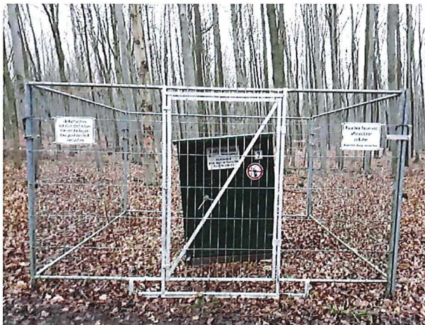
Abbildung 40: Bunker zur temporären Lagerung von Sprengmitteln.
