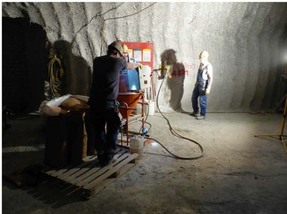
*Foto 18: Verpressen der Altbohrung A 821 am Nordstoß der 2. nördlichen Richtstrecke nach Osten mit ca. 2 m<sup>3</sup> Sorelbeton, Blick nach Norden (Stand: 29.04.2015)*
