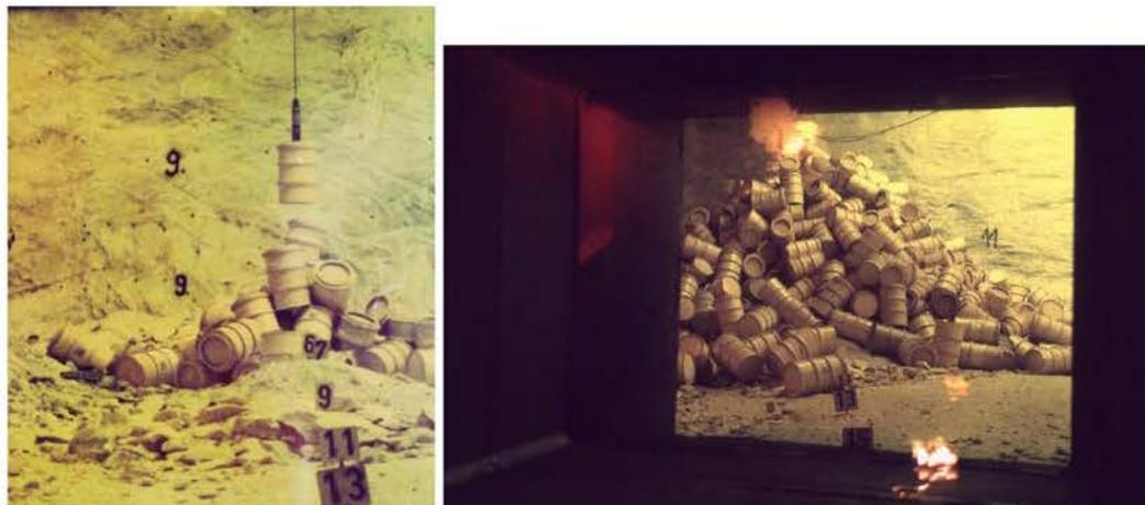
Abbildung 12.2: Fotoaufnahmen der MAW-Kammer auf der 511-m-Sohle. Linkes Bild: 1972, Rechtes Bild: 1984.
