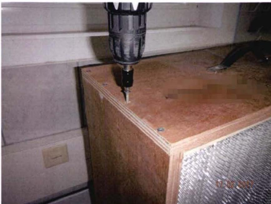
Abbildung 3: Die Schrauben am Filterelement wurden gelöst.
