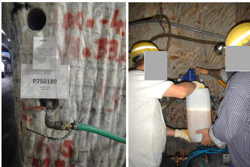
Bild 46 und 47: Lösungsaustritt in der Erkundungsbohrung 750-11.1 West auf der 750-m-Sohle, P750189.
