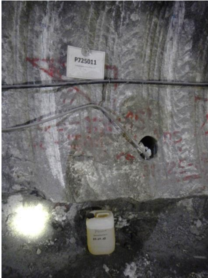
Bild 19: Erkundungsbohrung EBrG. SV-725-6.4 im Pfeiler 2-3/725 auf der 725-m-Sohle, P725011.
