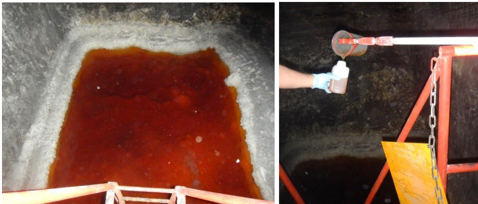
Bild 36 und 37: Sumpf im Stummelort gegenüber Schacht 4 (Querschlag zu den Kaliabbauen 1/750 und 2W/750) auf der 750-m-Sohle, P750039.
