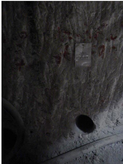
Bild 39: Lösungsaustritt in der Befüllbohrung BBrG. SV-750-12h.2 auf der 750-m-Sohle, P750184.
