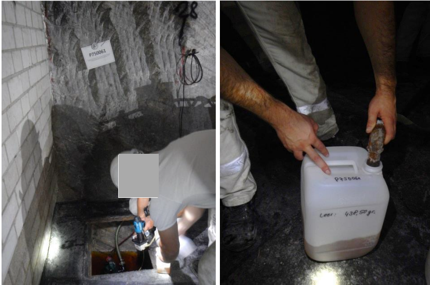
Bild 30 und 31: NE-Mauer des Resthohlraums RH-750-27 im NW-Kali-Feld 750, inkl. SW-Stoß/Sohle am NW-Ende der nördl. Richtstrecke nach Westen 750, zwischen den Lokalitäten P750008 und P750009, aktuell auch "Reichelt-Sumpf West" auf der 750-m-Sohle, P750061.
