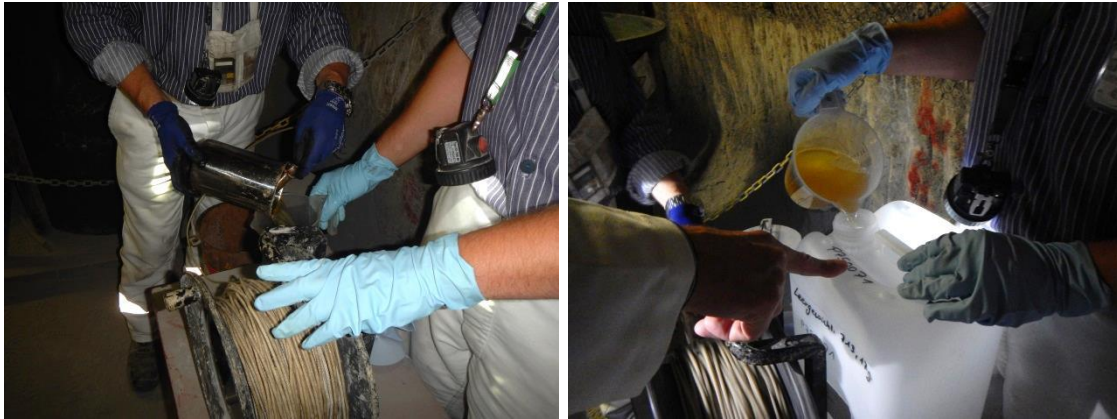
Bild 1 und 2: Austritt in der nördlichen Umfassung von Blindschacht 2/750 und aus dem Baugrund WL-750-16a (nördliche Mauer, nach der Auffahrung) auf der 750-m-Sohle, P750071.
