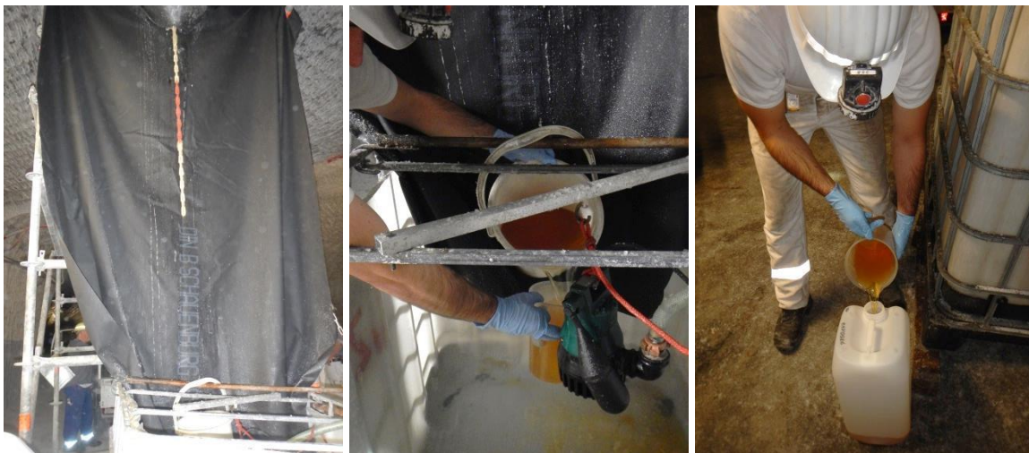
Bild 50 bis 52: Versorgungsbohrung von der 700-m-Sohle zur 800-m-Sohle, P750177.
