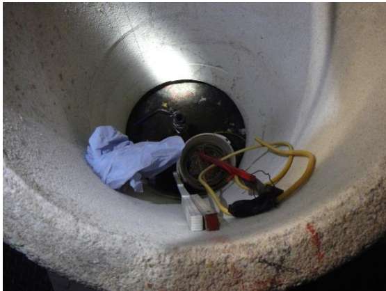
Bild 7: NE-Abschnitt der nördlichen Richtstrecke nach Osten, vor dem Sumpf vor Einlagerungskammer 12/750 (4. von 15 Sohlbohrungen/Laugekontrollbohrungen) auf der 750-m-Sohle, P750084.
