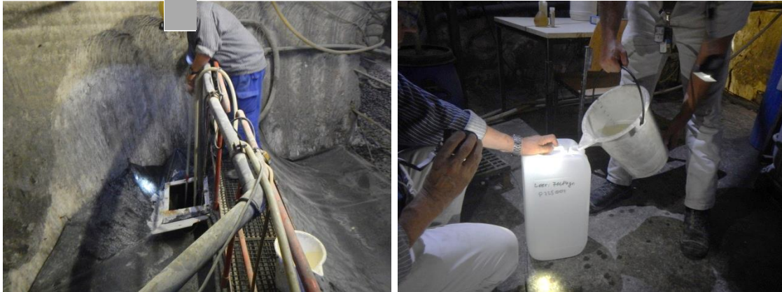
Bild 16 und 17: Schramm und Sumpf in der Richtstrecke nach Westen 725 (Sohlenniveau, Gleitbogenstrecke, ABR3) im Pfeiler 2-3 auf der 725-m-Sohle, P725004.
