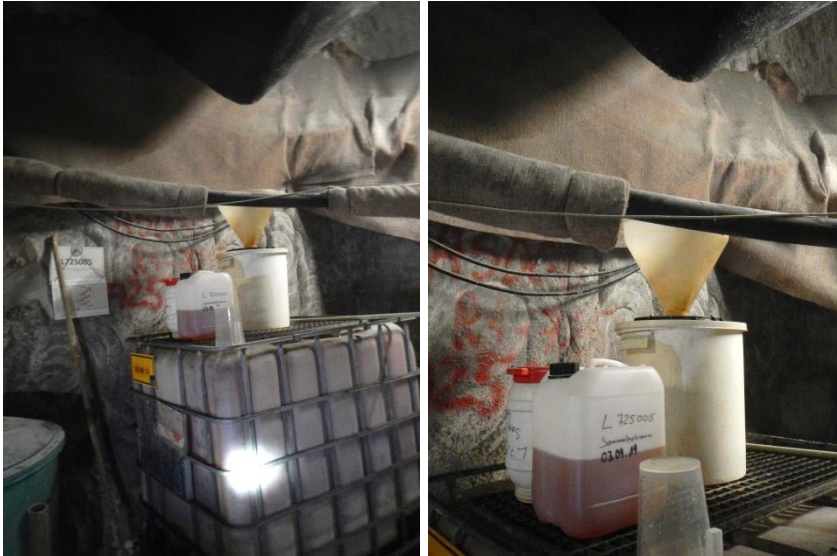
Bild 11 und 12: Rolloch R1/725 in der Richtstrecke nach Westen 725 (Sohlenniveau, Gleitbogenstrecke) im Pfeiler 1-2/725, auf der 725-m-Sohle, L725005.
