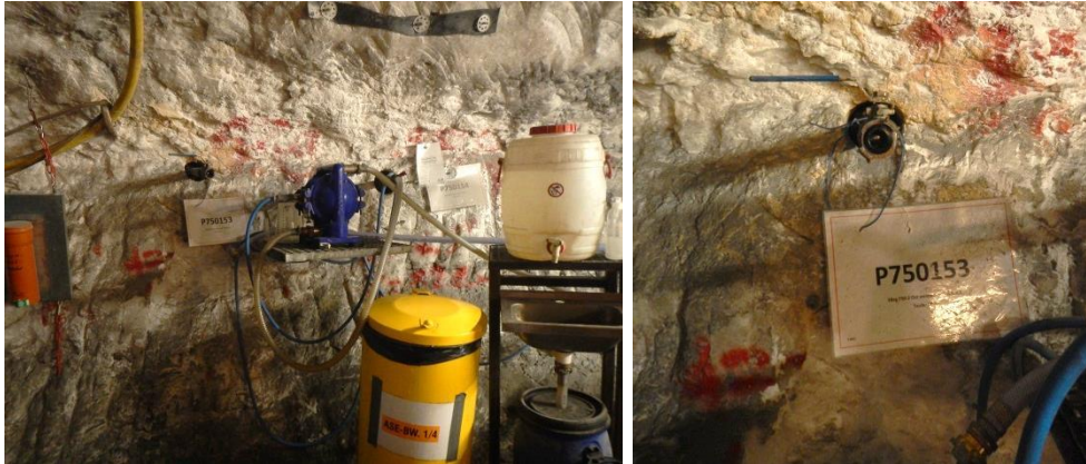
Bild 40 und 41: Geneigte Erkundungsbohrung EBrG. 750-2 Ost westlich des Blindschachtes 4/750 in Richtung des Kali-Abbaues 3E/750 auf der 750-m-Sohle, P750153.
