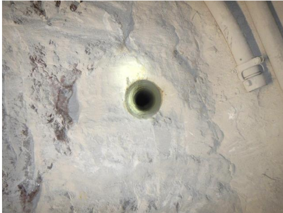
Bild 38: Lösungsaustritt in der Befüllbohrung BBrG. SV-750-12h auf der 750-m-Sohle, L750179.
