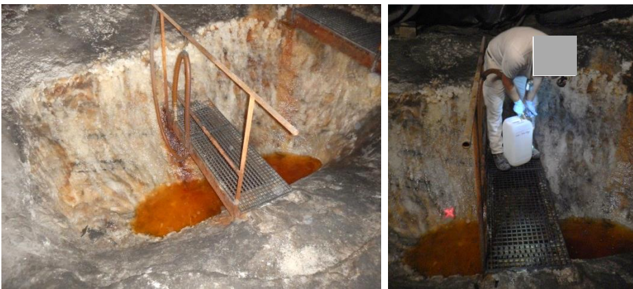
Bild 32 und 33: Sumpf im Stummelort gegenüber dem ehem. Sprengstoff-Magazin (Querschlag zu den Kaliabbauen 3W/750 und 4W/750) auf der 750-m-Sohle, P750040.
