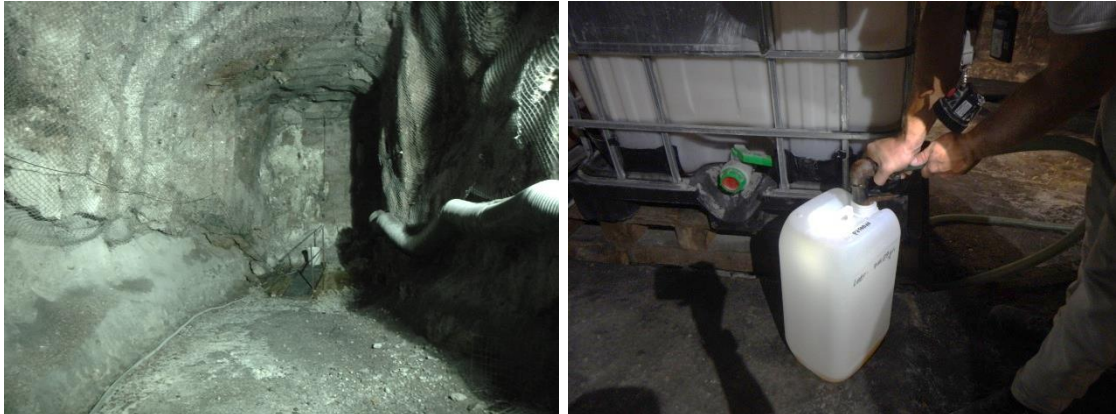
Bild 26 und 27: Sumpf im Zugang zum Kaliabbau 11W/750 (NW-Kali-Feld, „Reichelt-Sumpf Ost“) auf der 750-m-Sohle, P750010.
