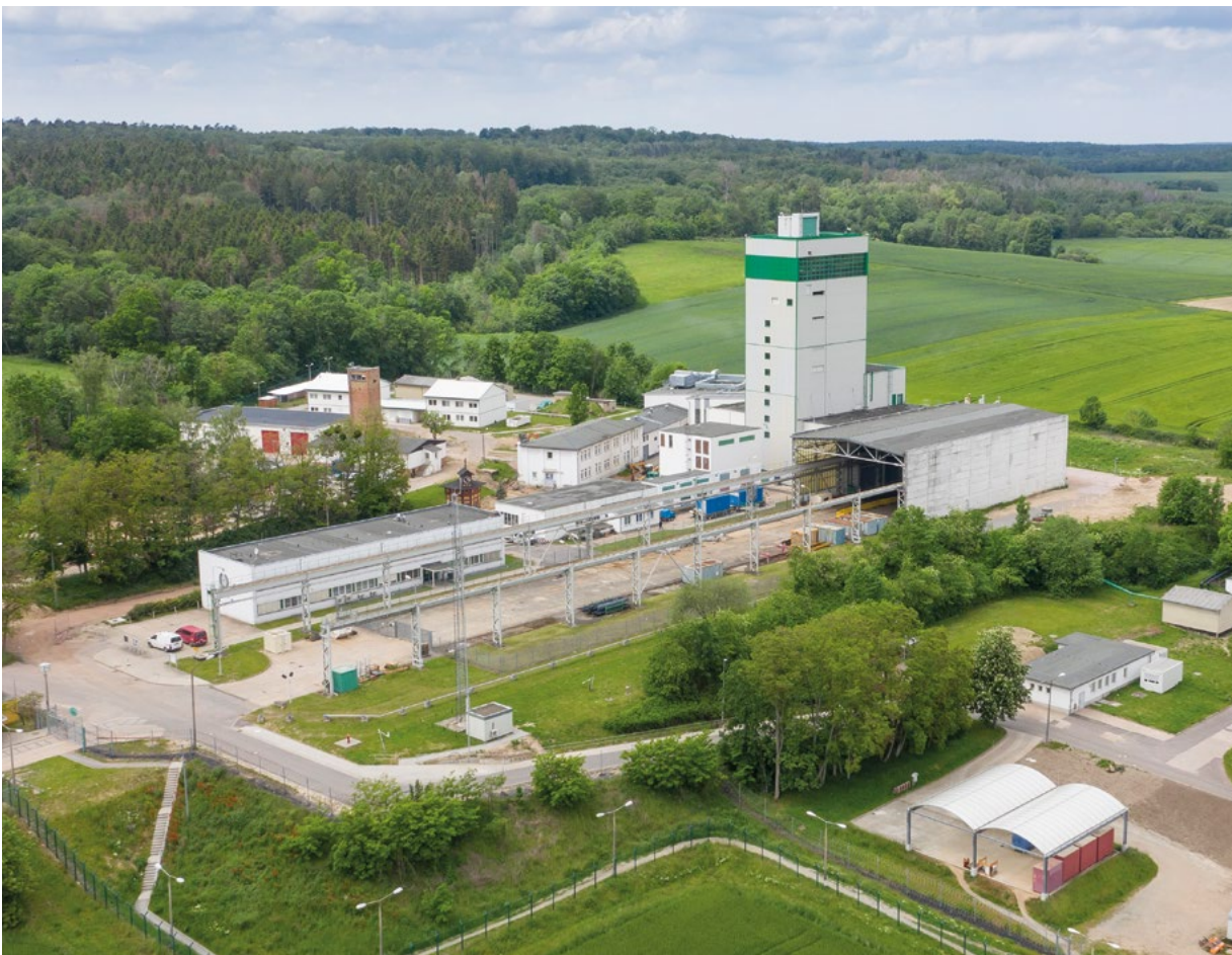
Luftbild des Endlagers Morsleben.
