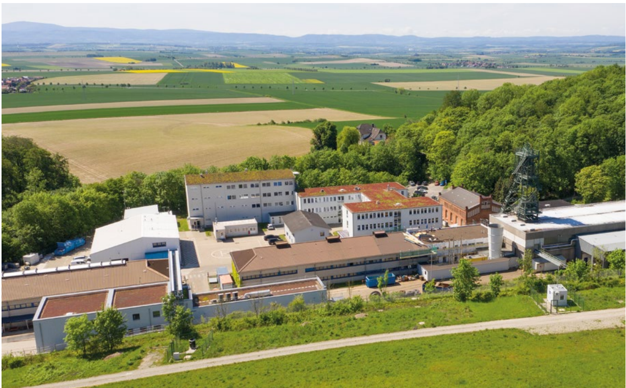
Luftbild der Schachtanlage Asse II.
