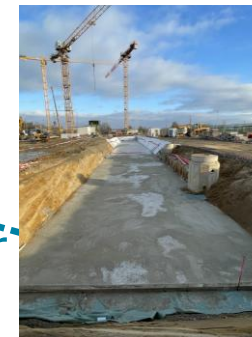
Betonage Umladehalle Bauteil A2
