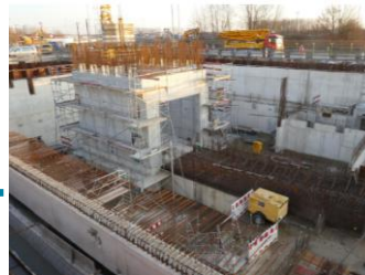
Betonage Diffusor Lüftergebäude
