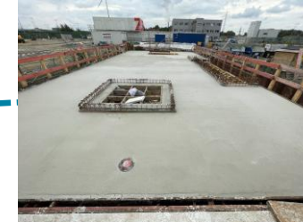
Betonage Kellerdecke Umladehalle
