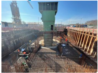
Errichtung Schachtkeller
