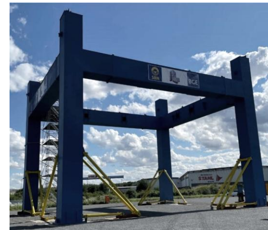
Fertigstellung Förderturm Unterteil 2024
