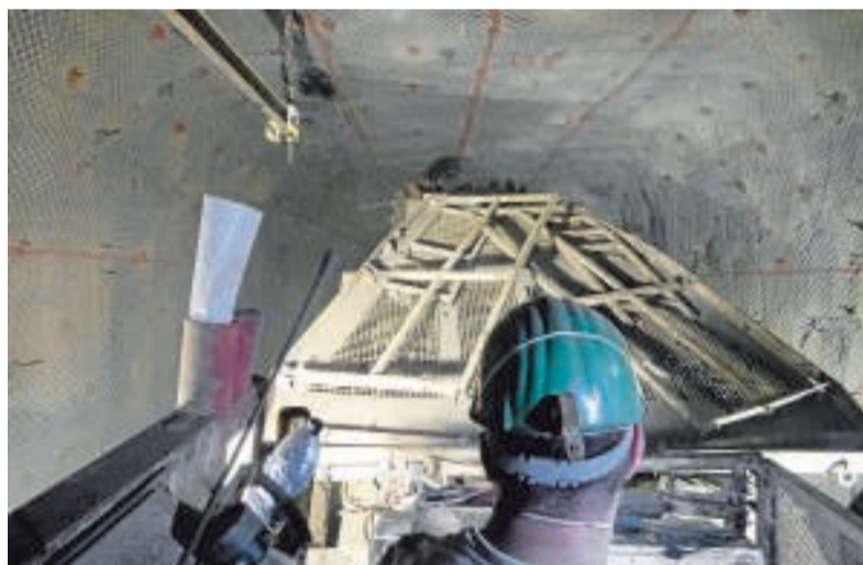
Maschinenführer Nedim Mujezinovic bedient die Teilschnittmaschine, an deren Ende der tonnenschwere Bohrkopf befestigt ist. Sie frisst sich täglich rund vier Meter ins Gestein.
