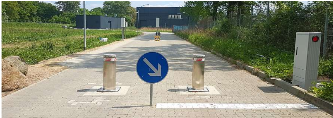
Abbildung 7: Hydraulisch absenkbarer Poller mit LED Signalen im oberen Teil [37]
