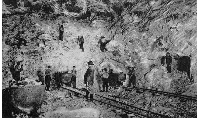
Abbau von Steinsalz ohne elektrische Energie: Gebohrt wird mit der Handbohrmaschine. Die Förderwagen werden mit einer Spitzschaufel beladen.
