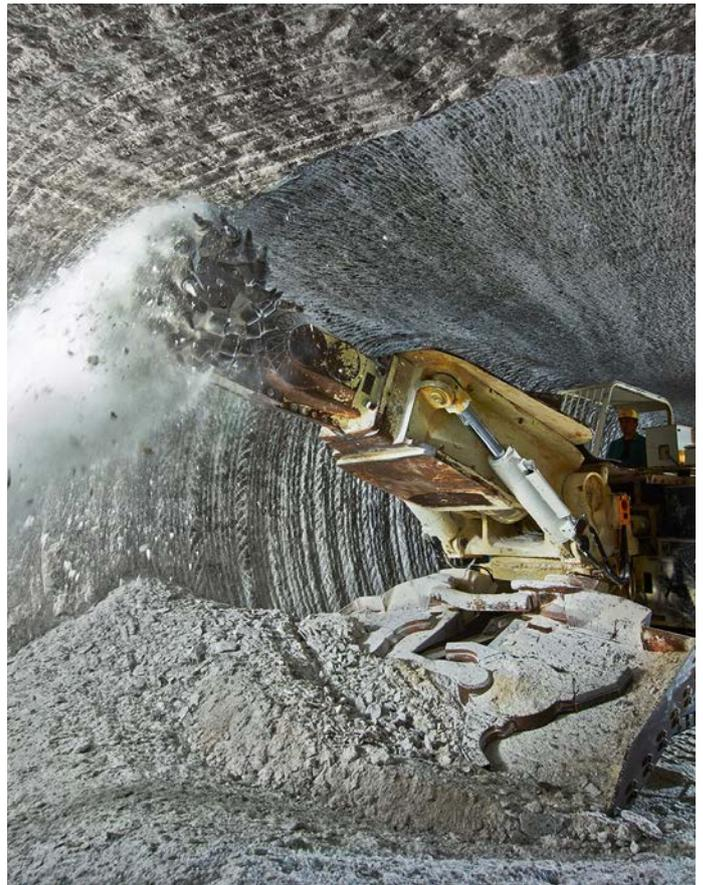
Die Modernisierung von Verbindungsstrecken minimiert den Wartungsaufwand und ermöglicht die Befahrung mit größerer Technik – eine Vorbedingung für die spätere Stilllegung des Endlagers.
