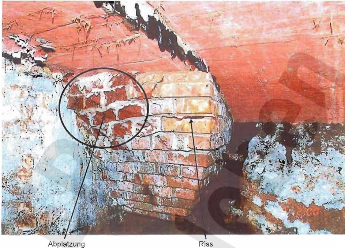
Bild 7: Gewölbe bei -194 mNN GS 5 und GS 6 - Schädigungen an der als Gewölbewiderlager gemauerten Konsole am westlichen Stoß unter GS 5 Stand: 09.02.00
