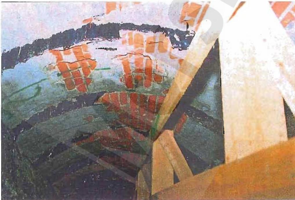
Bild 5: Gewölbestufen von -187 mNN bis -188 mNN GS 12 bis GS 20 mit Abschaltungen im Scheitelbereich, Stirnflächen mit Asphalt
