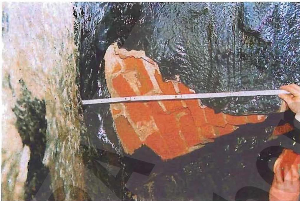
Bild 4: Gewölbesegment 20 bei ca. -187 mNN; ältere Abplatzung an der Stirnfläche
