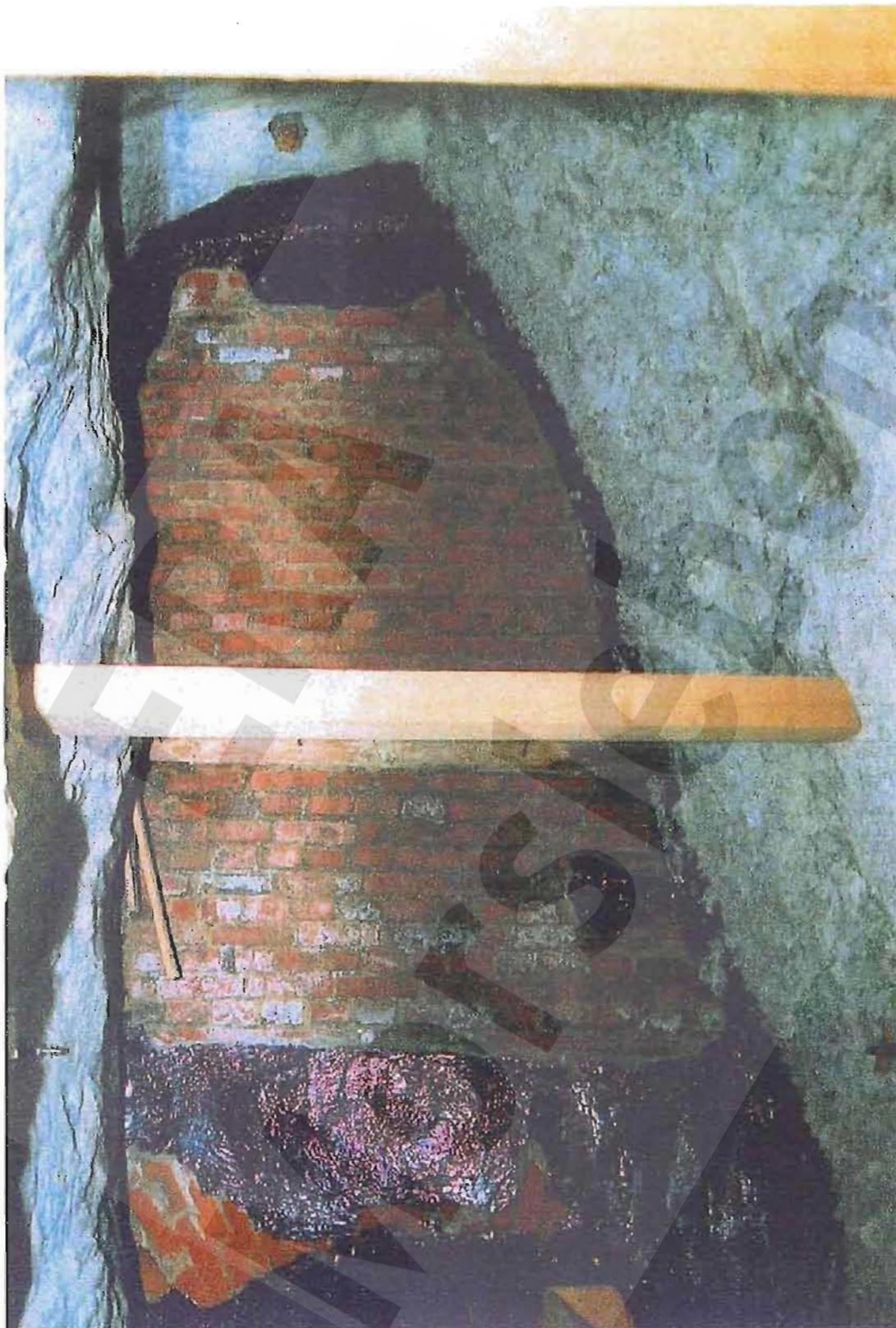
Bild 3: Gewölbesegment 20 von ca. -184 mNN bis -187 mNN Stirnfläche mit Konvergenzstrecke CG001K im Salinar
