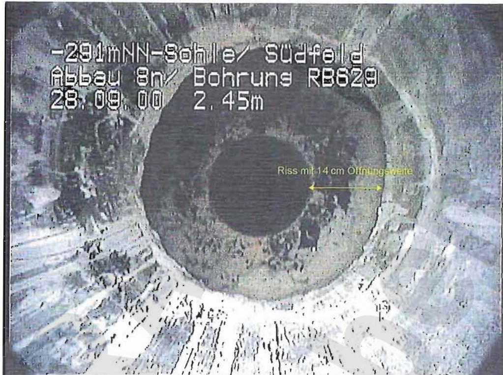
Bild 1: Riss in der Schweben zwischen den Abbauen 8 n der -291 mNN und -305 mNN Sohle
