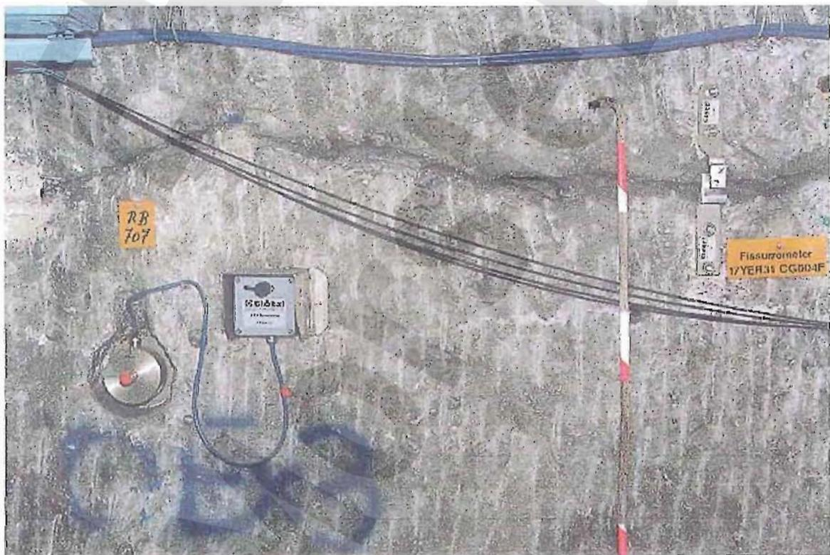
Bild 3: Rissverlauf am Oststoß der 1. südl. Richtstrecke der -372 mNN Sohle
