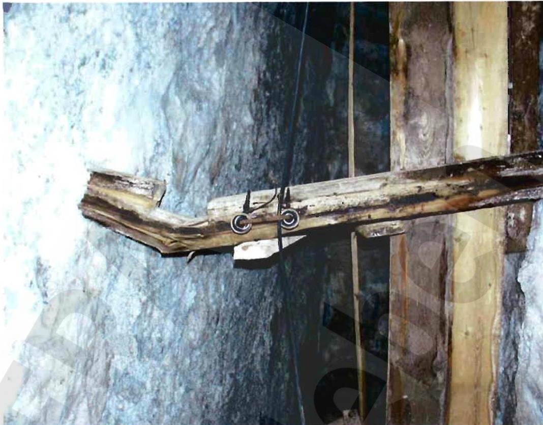
Bild 9: Lager H – gebrochener horizontal querschlägig eingebauter Bühnenträger bei -188 mNN im Januar 2002. Während der Sicherungsarbeiten Ende 2002 wurde der Träger erneuert.
