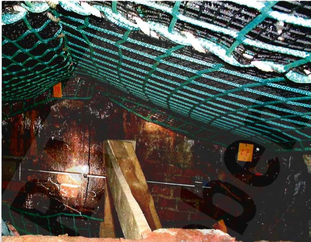
Bild 3: Stirnfläche Gewölbesegment 11 bei -188 mNN mit den Messstrecken CG007K und CG008E mit Messuhr
