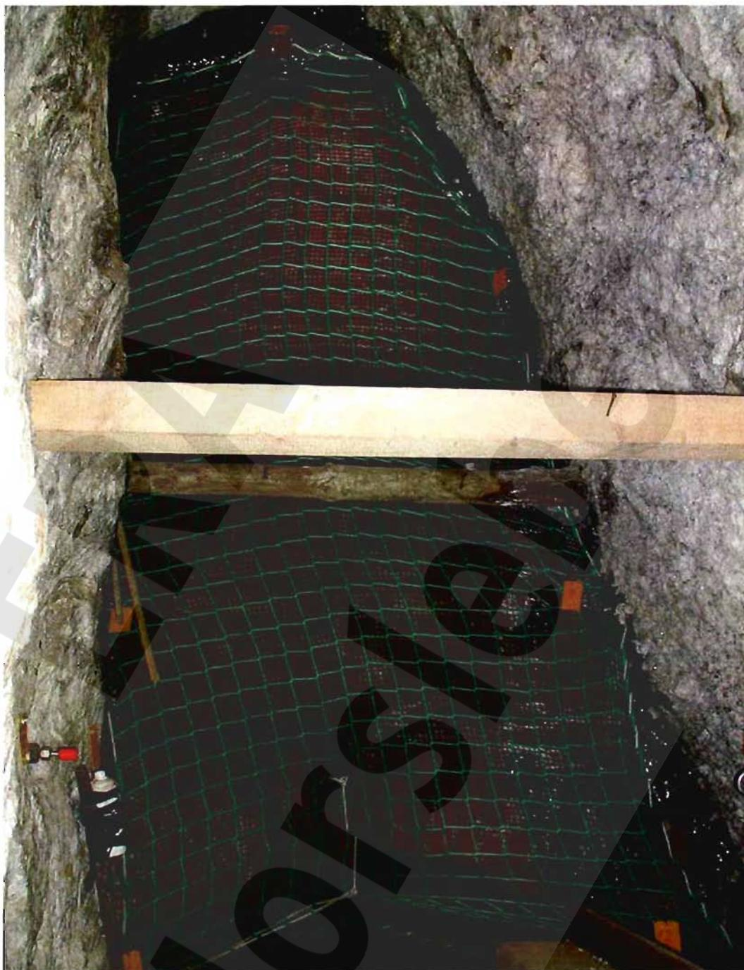
Bild 4: Gewölbesegment 20 von ca. -184 mNN bis -187 mNN Stirnfläche mit Konvergenzstrecke CG001K im Salinar
