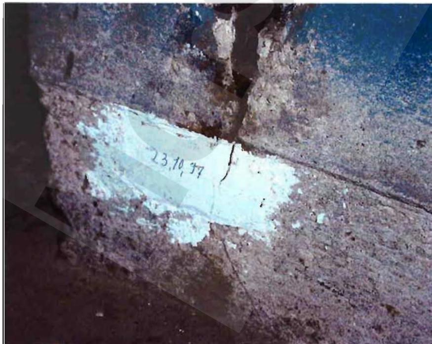
Bild 2: Schacht Bartensleben Füllortkeller -372 mNN Sohle -NW- vertikaler Riss im Schachstuhlfundament
