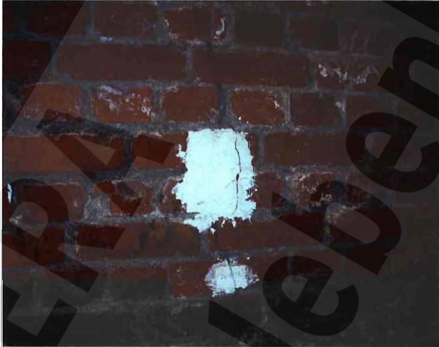
Bild 1: Schacht Bartensleben Füllortkeller -372 mNN Sohle -SE- vertikaler Riss im Mauerwerk
