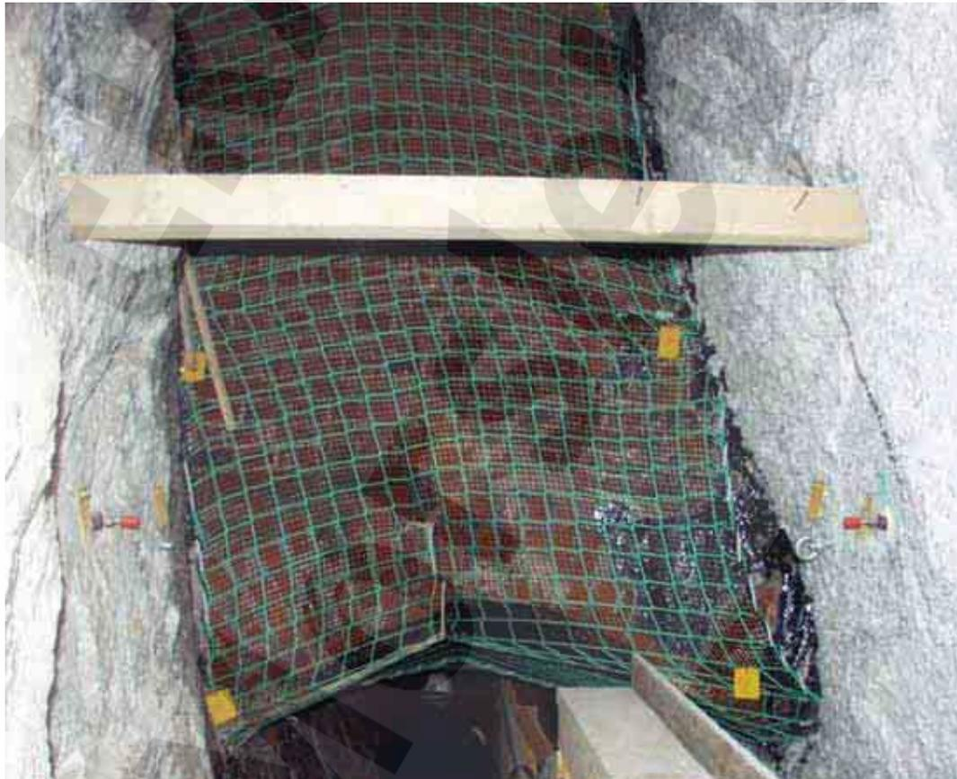
Abbildung 4: Gewölbesegment 20 von ca. -184 mNN bis -187 mNN Stirnfläche mit Konvergenzstrecke CG001K im Salinar. Stand: 11.02.05
