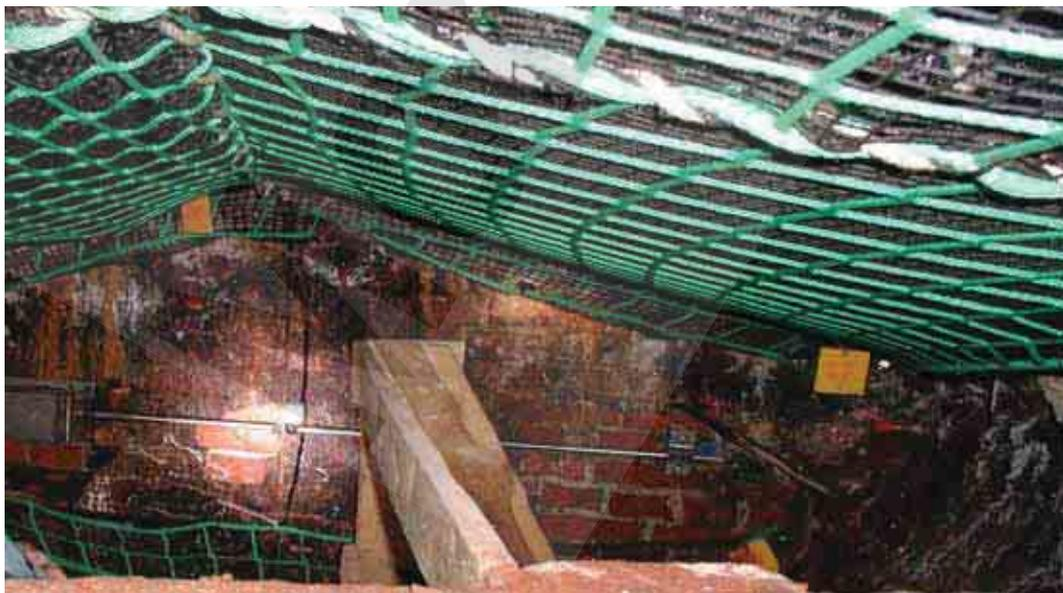
Abbildung 3: Stirnfläche Gewölbesegment 11 bei -188 mNN mit den Messstrecken CG007K und CG008E mit Messuhr.
