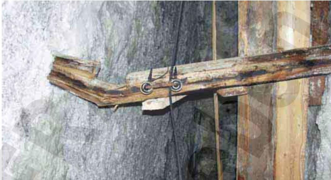
Abbildung 10: 02YER71/R001 (Lager H) – gebrochener horizontal querschlägig eingebauter Bühnenträger bei -188 mNN in 01/02. Während der Sicherungsarbeiten Ende 2002 wurde der Träger erneuert.
