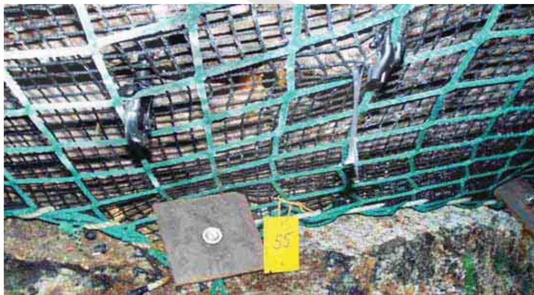
Abbildung 7: Austretender Asphalt bei -194 mNN an den Gewölbesegmenten GS 8 und GS 9.
