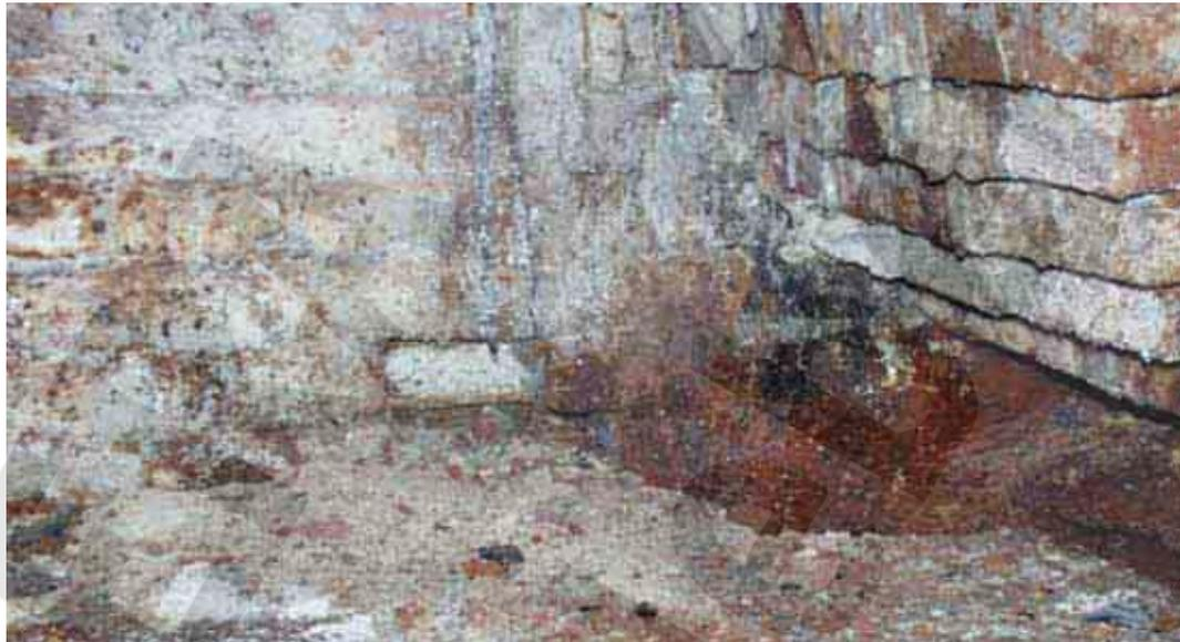
Abbildung 6: Gewölbesegment GS 5 bei -194 mNN, weggebrochener Mauerfuß.
