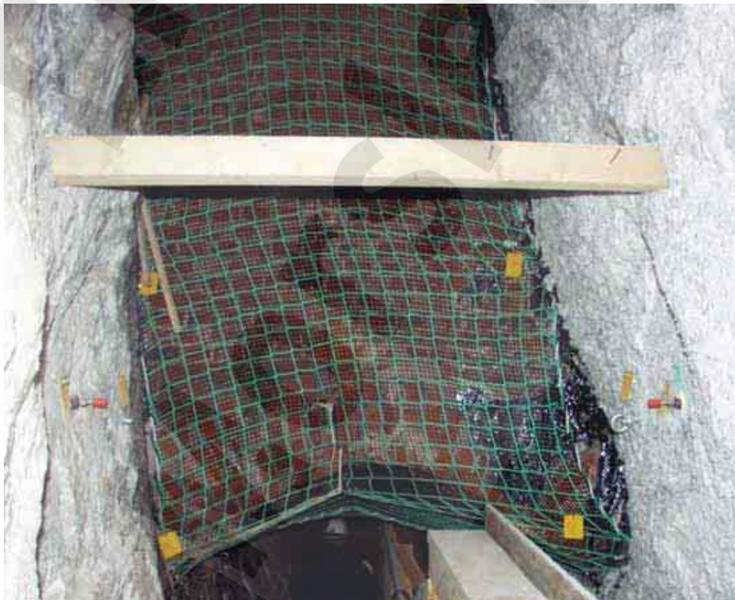
Abbildung 4: Gewölbesegment 20 von ca. -184 mNN bis -187 mNN Stirnfläche mit Konvergenzstrecke CG001K im Salinar. Stand: 11.02.2005
