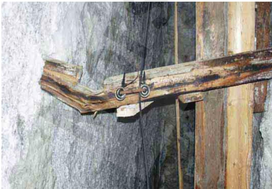
Abbildung 10: 02YER71/R001 (Lager H) – gebrochener horizontal querschlägig eingebauter Bühnenträger bei -188 mNN in 01/02
