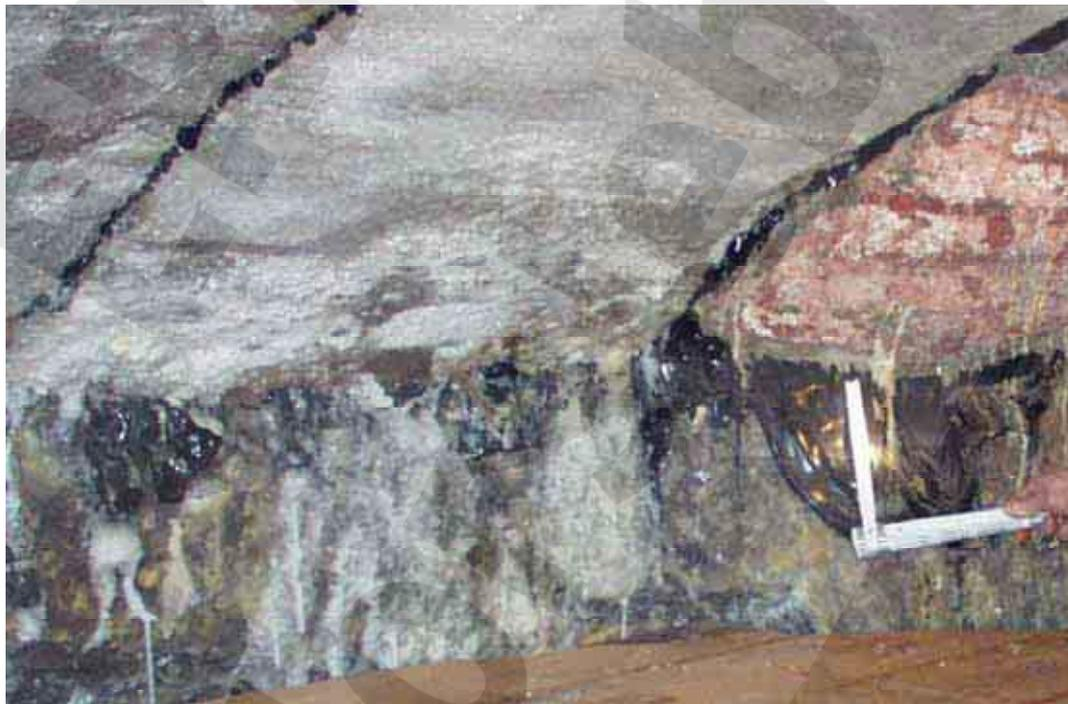
Abbildung 9: Austretender Asphalt bei -202 mNN am Gewölbesegment GS 1. Stand: 23.01.2006
