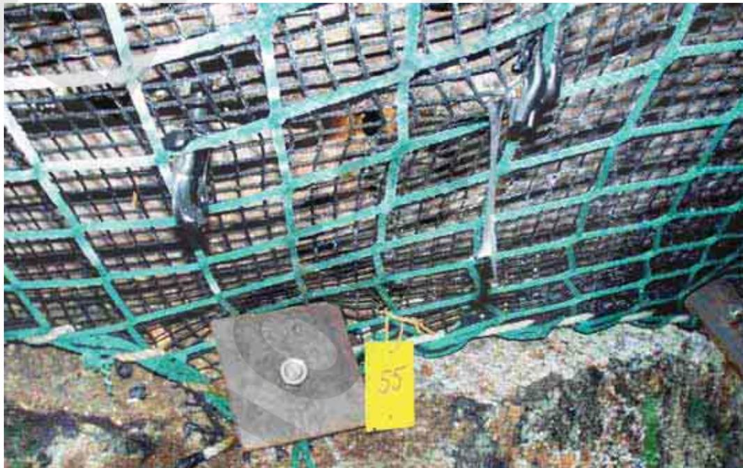
Abbildung 8: Austretender Asphalt bei -194 mNN an den Gewölbesegmenten GS 8 und GS 9. Stand: 21.01.2004
