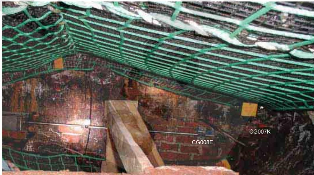
Abbildung 3: Stirnfläche Gewölbesegment GS 11 bei -188 mNN mit den Messstrecken CG007K und CG008E mit Messuhr. Stand: 26.02.2003
