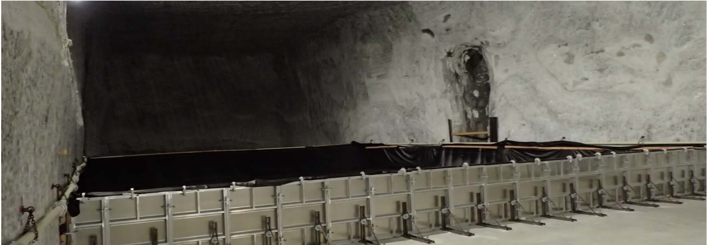
Errichtung Auffangbecken im Abbau 1s auf der 3. Sohle für den Probebetrieb der Baustoffanlage
