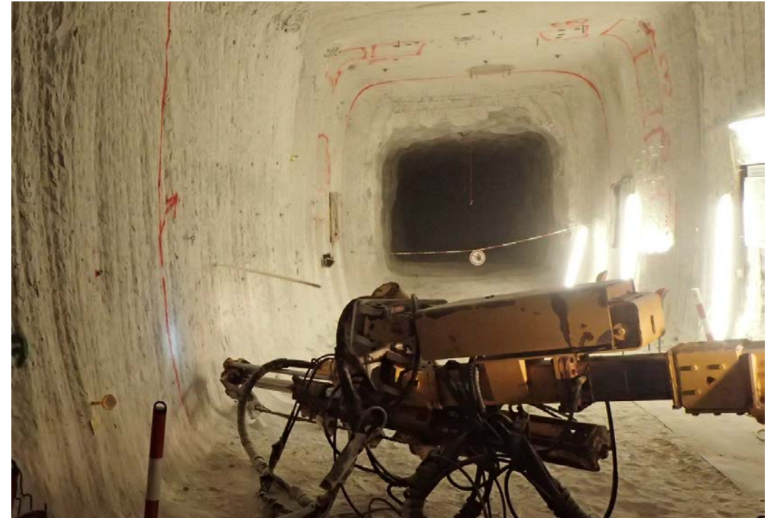
Erweiterung des Vorraums am Standort des Demonstrationsbauwerk auf der 3. Sohle mittels Bohr- und Sprengtechnik
