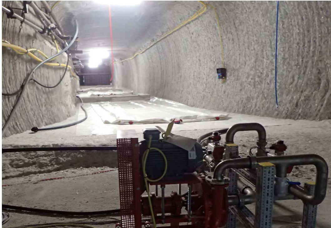
Lieferung und Montage von drei Faltbehältern zur Lagerung von Anmachflüssigkeit im Ausrichtungsquerschlag 2. Sohle
