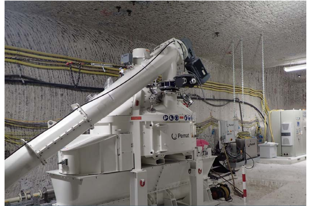
Lieferung und Montage der semimobilen Baustoffanlage auf der 2. Sohle
