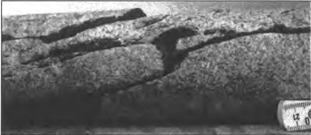
Abbildung 43: Beispiel für offene Klüfte, Bohrung RB 530, Länge der unteren Bildkante entspricht ca. 20 cm
