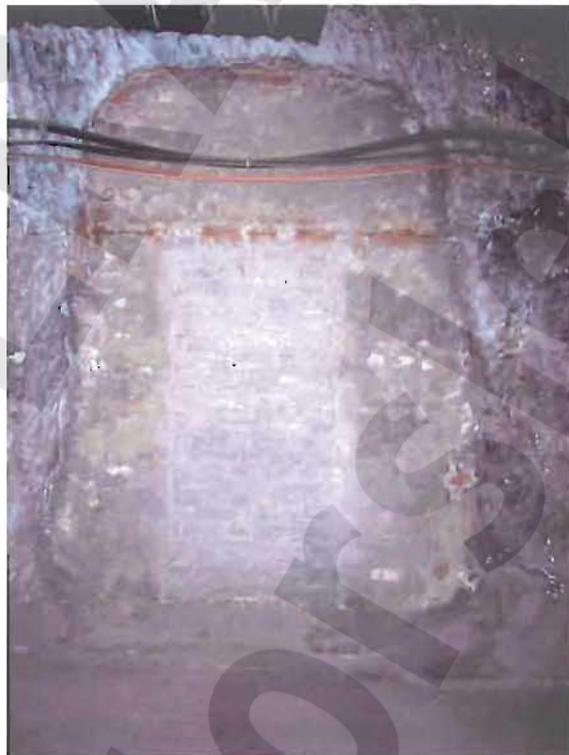
**Abb. 8: Abmauerung von Station 9,6 m bis Station 11,8 m**
