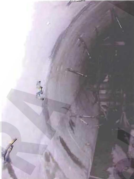
Abb. 28: Zuführungsschläuche im Befahrungs- und Injektionskanal zur Beschickung der Verpressschläuche (Bsp. AV/Blumenthal)
