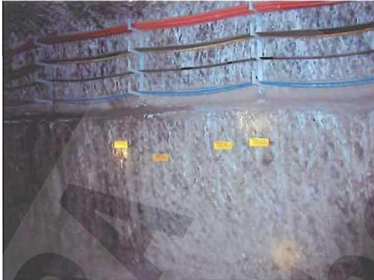
**Abb. 14:** Kabeltrasse mit den darunter befindlichen Untersuchungsbohrungen
