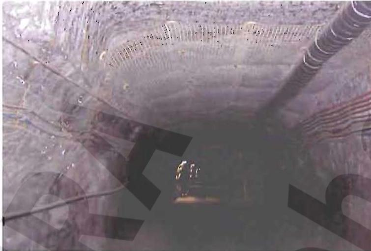
**Abb. 12: Firsicherung im Ostquerschlag (17YEQ01/R001)**
