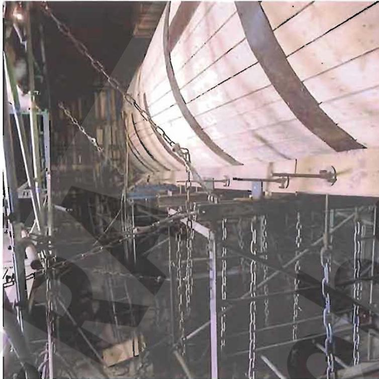
**Abb. 27: Befahrungs- und Injektionsrohr (Dammrohr) mit Unterbau und Auftriebssicherung (Bsp. AV/Blumenthal)**
