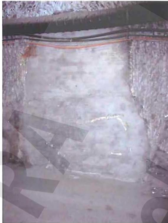
**Abb. 9: Abmauerung von Station 5,0 m bis Station 7,5 m**
