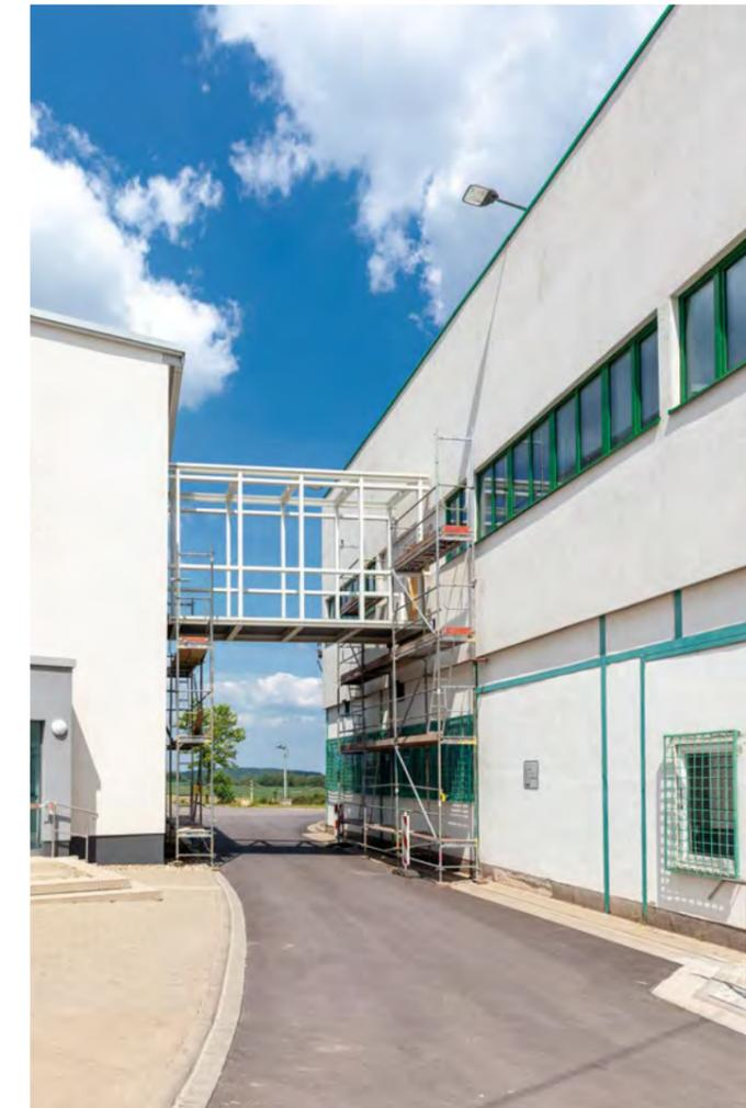
Endlager Morsleben, Tragkonstruktion für neue Seilfahrtsbrücke
