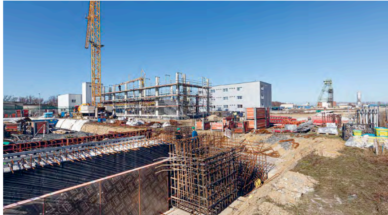
Schachtanlage Konrad: Am Schacht Konrad 2
