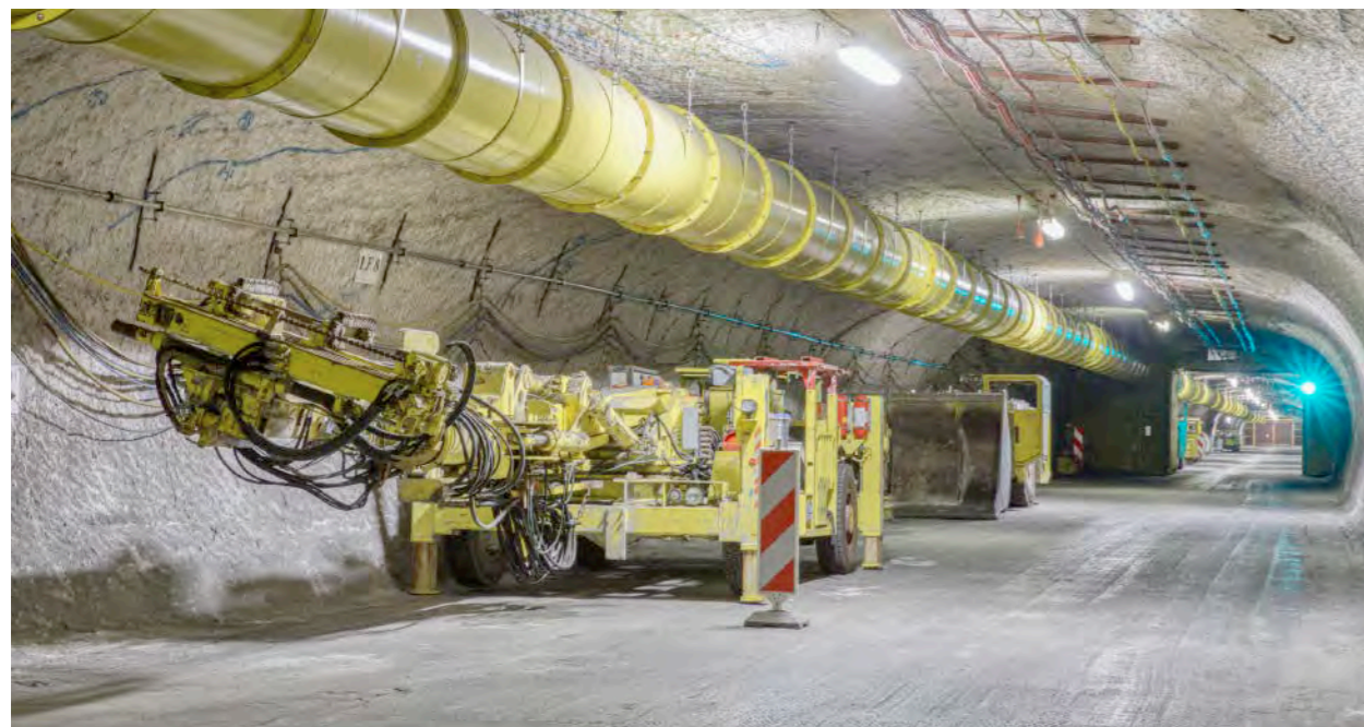
Bergwerk Gorleben: Hauptförderstrecke, 840-m-Sohle
