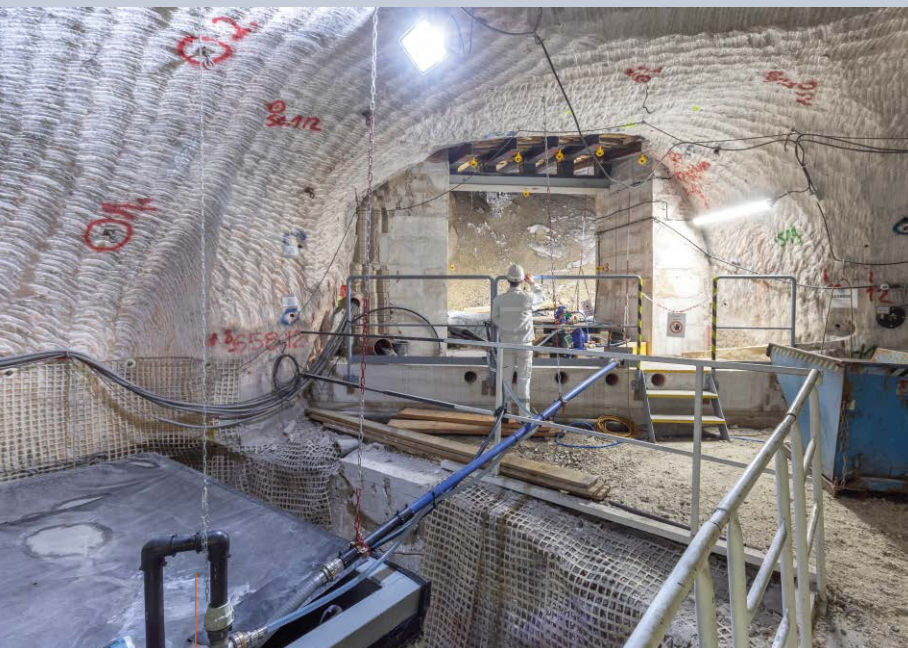
Schachtanlage Asse: Hauptauffangstelle auf der 658-Meter-Sohle
