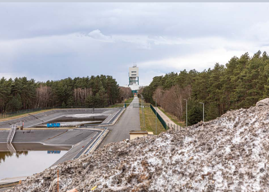
Bergwerk Gorleben: Der Rückbau hat begonnen
