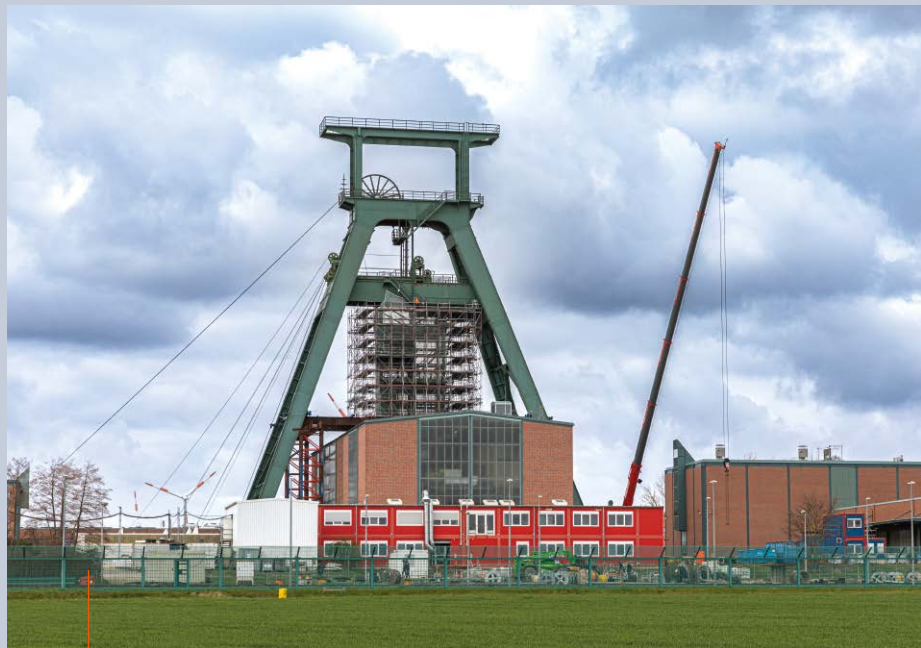
Schachtanlage Konrad: Vorbereitung auf den Führungsgerüstwechsel
