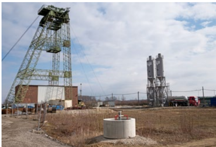
Noch unvollendet: Blick auf das Gelände des Endlagers nahe Salzgitter, wo der Schacht 2 ausgebaut wird
