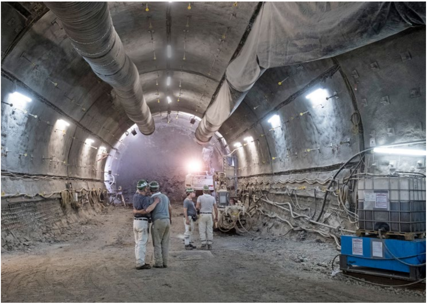
Blick in die nahe Zukunft: Hier entsteht die Montagehalle, in der die Fahrzeuge aus dem Einlagerungsbereich gewartet und gewaschen werden
