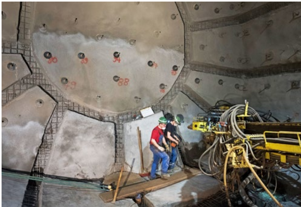
Härtetest: Für den Bau des Endlagers werden viele Gerätschaften benötigt
