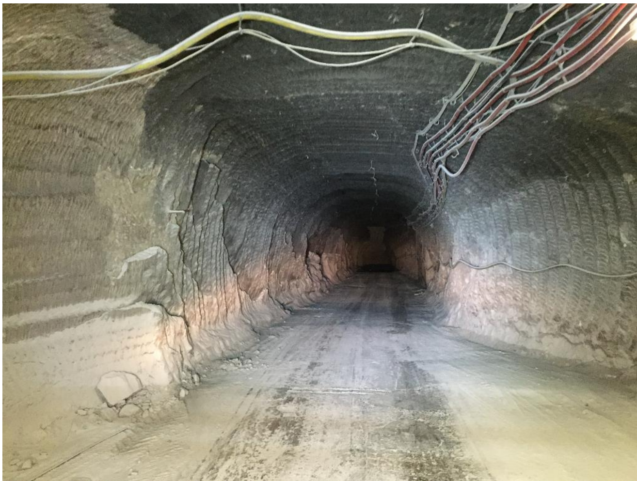
Quelle: BGE Asse II – 725-m-Sohle
